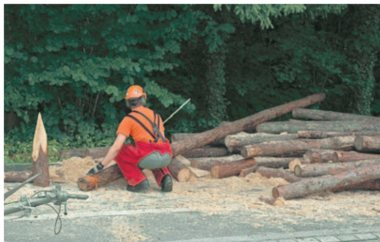
Mit Baumstämmen wurde ein unterspülter Waldweg aus- und aufgebaut.
